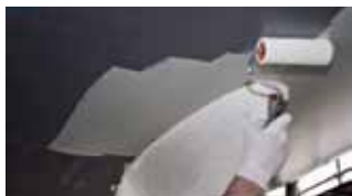
Apply antifouling over primer
