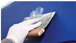
Fill using blade
